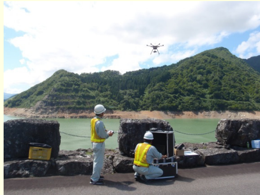
UAVによる空中写真の撮影
